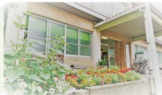
▲ 千葉県障害者就労事業振興センター：外観
